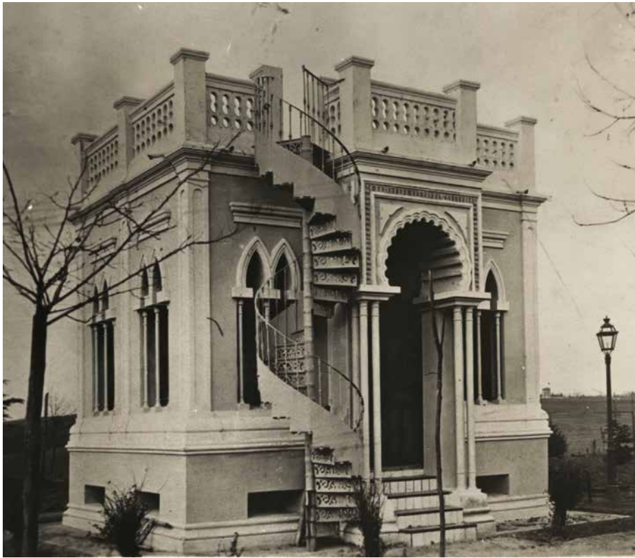
79. Il Kiosco Árabe costruito davanti alle manzanas 89 e 90, tra il Parque de diversiones e l'Hotel Rubín. (FLLCHU, GCCLP, box 2, AB014).
