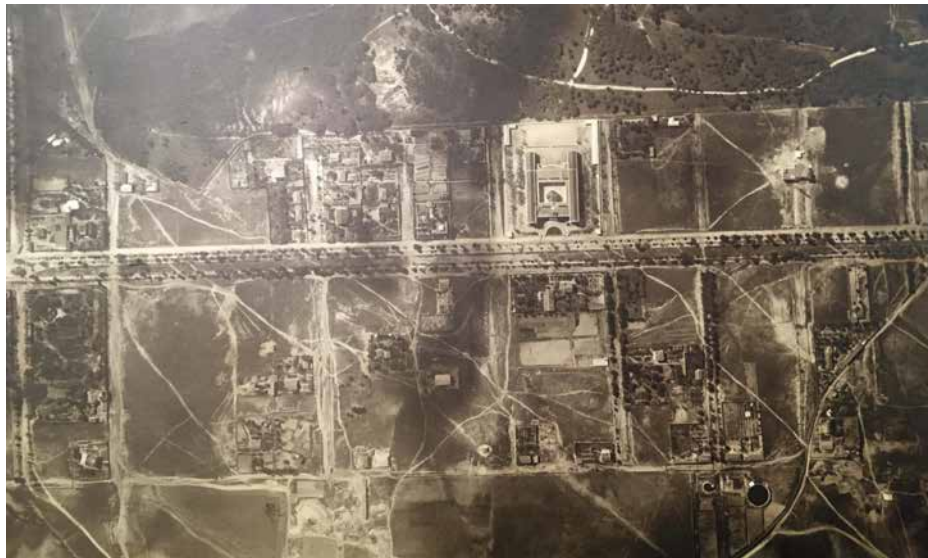
186. Foto area delle manzanas 69 in cui è costruito il Colegio de Huérfanos de la Armada (APCMU, Vistas Aéreas, 1931).
