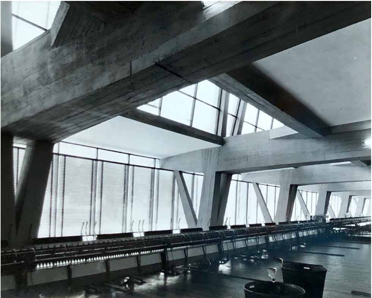
158. Fabbrica per filature Goti, Campi Bisenzio, 1959-1962: fotografia dell'interno del salone centrale con la sequenza di pilastri ramificati in tre bracci (Archivio CSAC, Parma, fondo Leonardo Ricci).
