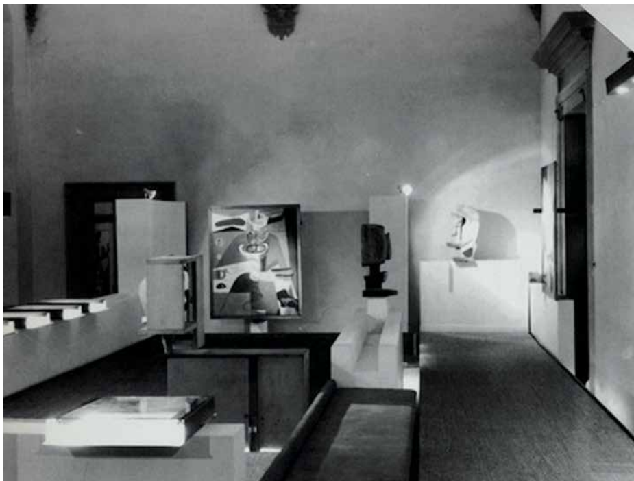
125. Leonardo Savioli, allestimento per la mostra "Le Corbusier architetto pittore e scultore" a Palazzo Strozzi, Firenze, 1964 (su concessione del Ministero per i Beni e le Attività Culturali, Archivio di Stato di Firenze, fondo Leonardo Savioli, materiale fotografico, positivi, scatola 10).
