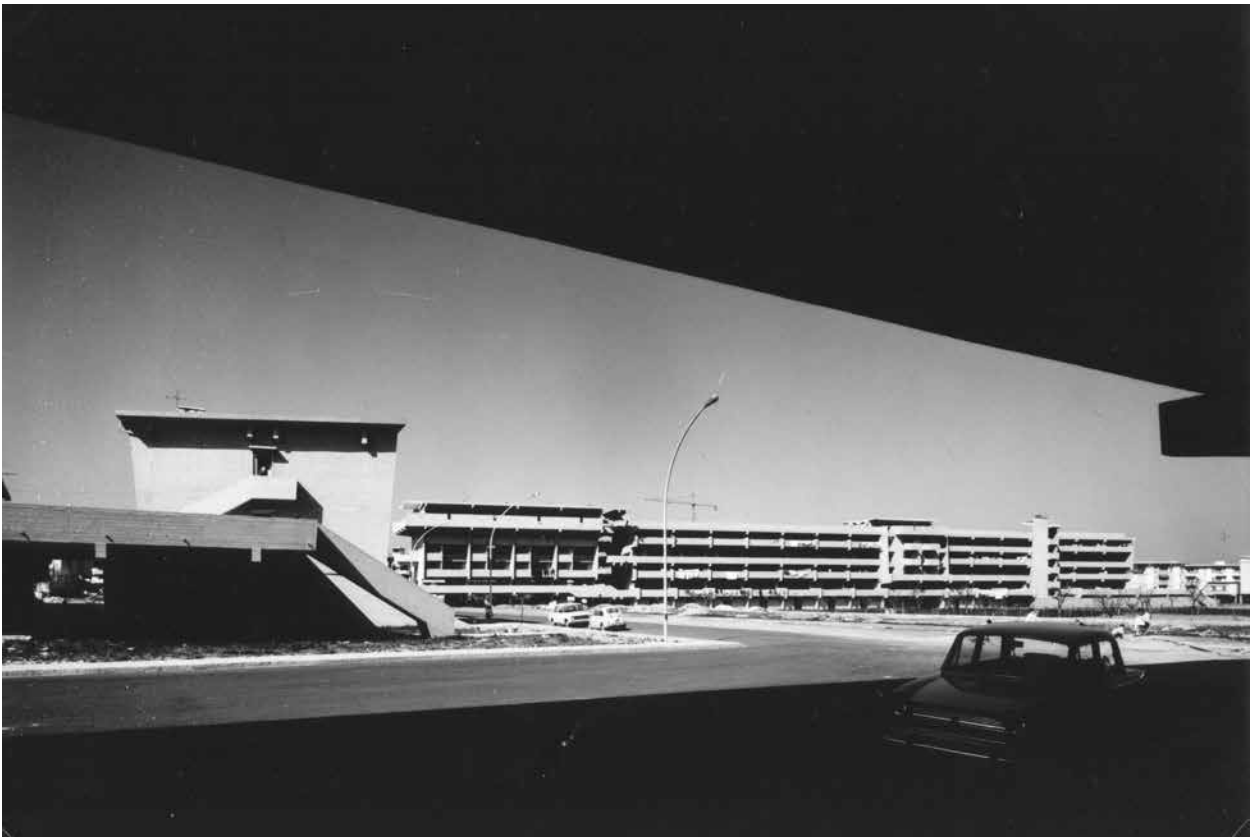
167. La Nave di Sorgane appena realizzata, 1966 (foto Giuliano Gameliel, casa-studio Ricci, Monterinaldi).
